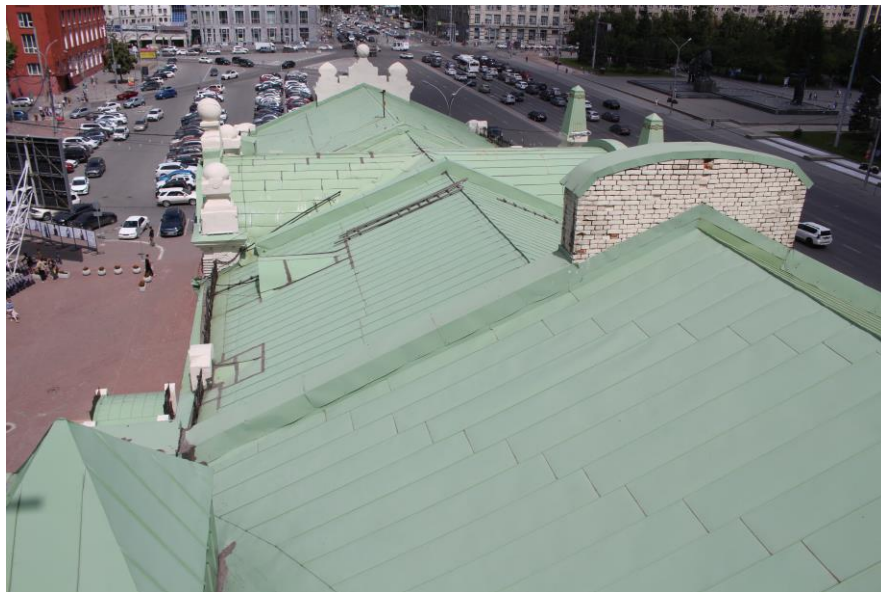
Илл. 6. Вид на фрагмент кровли исследуемого объекта, июнь 2022г.
