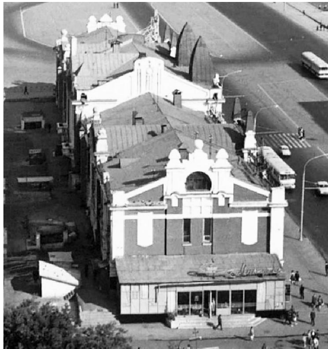
Илл. 2. Вид сверху на здание бывшего Торгового корпуса. Фотография 1950-1980-е гг. Пожарная башня на кровле утрачена.
